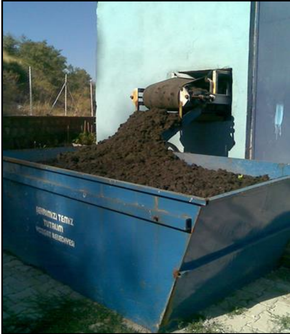
Şekil 3.20. Yozgat Atıksu Arıtma Tesisi – Çamur Çürütme Havuzu
