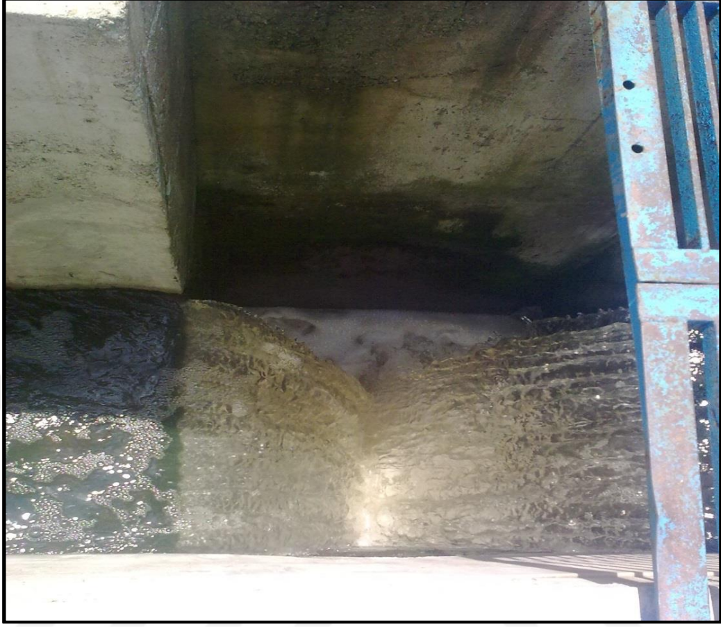
Şekil 3.15. Yozgat Atıksu Arıtma Tesisi – Son Çökeltme Havuzu Çıkış Suyunun Alıcı Ortama Deşarj Edilen Noktası
