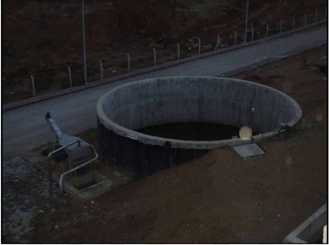
řekil 3.49. Kırřehir Atıksu Arıtma Tesisi – amur Depolama Tankı
