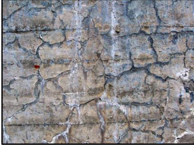
Şekil 2.31. ASR ye Maruz Kalmış Beton [2]
