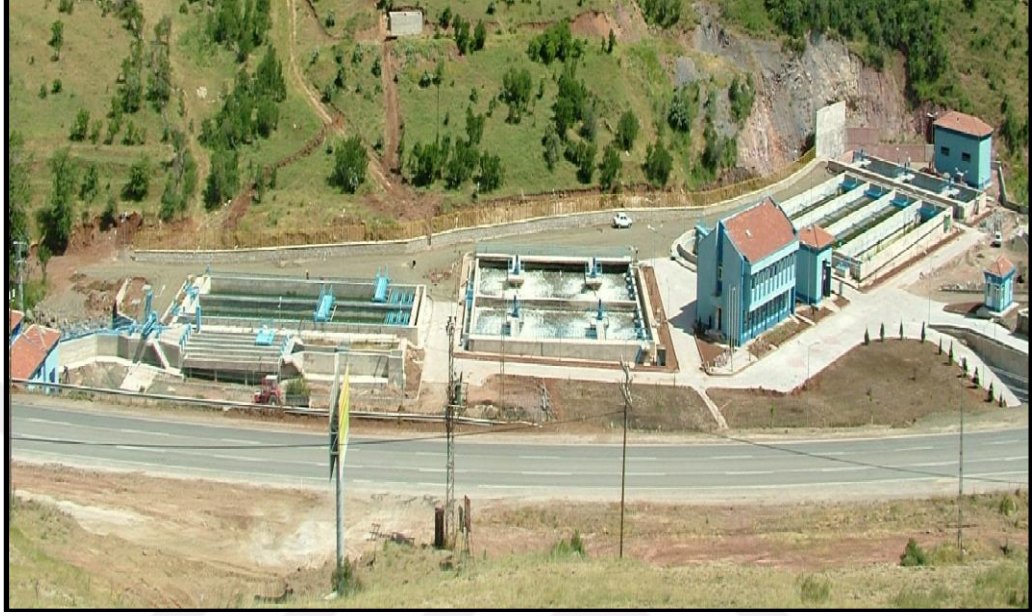
Şekil 3.1. Yozgat Atıksu Arıtma Tesisi Genel Görünüşü
