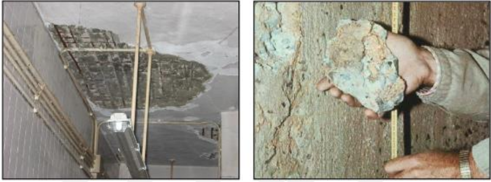
Şekil 2.20. Yüzeyde Dökülme [1]
