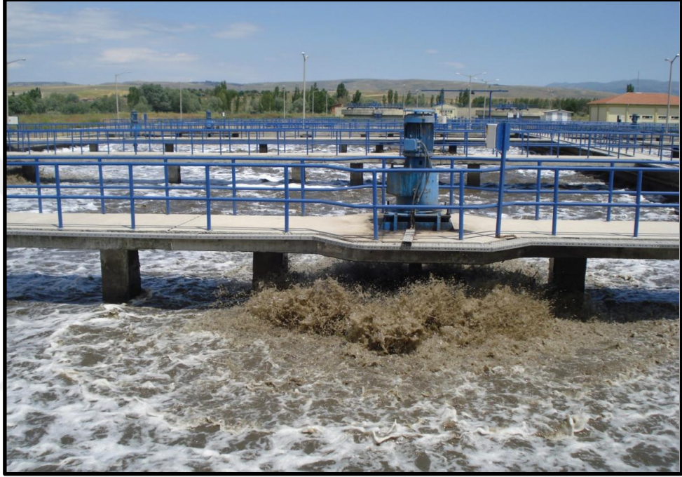
Őekil 3.55. orum Atıksu Arıtma Tesisi – Havalandırma Havuzları
