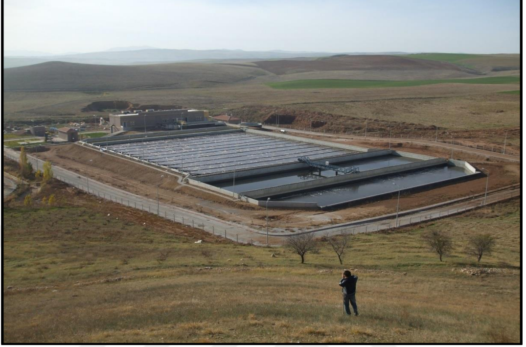
Şekil 3.38. Kırşehir Atıksu Arıtma Tesisi Genel Görünüşü
