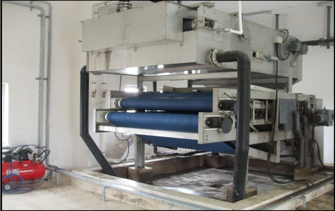
řekil 3.50. Kırřehir Atıksu Arıtma Tesisi – amur Susuzlařtırma nitesi
