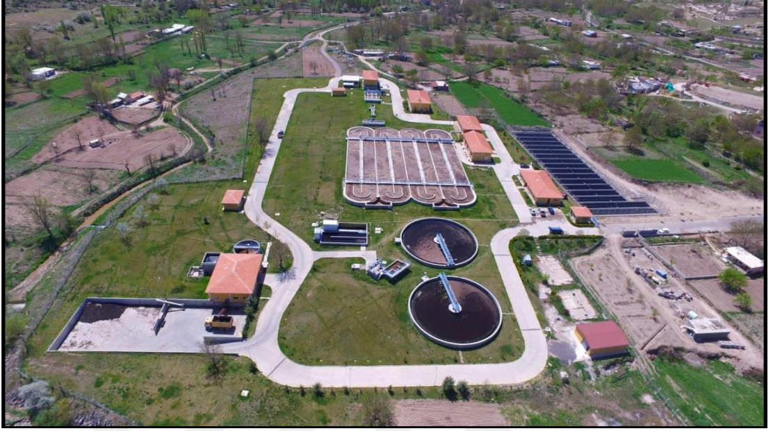
Şekil 3.21. Nevşehir Atıksu Arıtma Tesisi Genel Görünüşü
