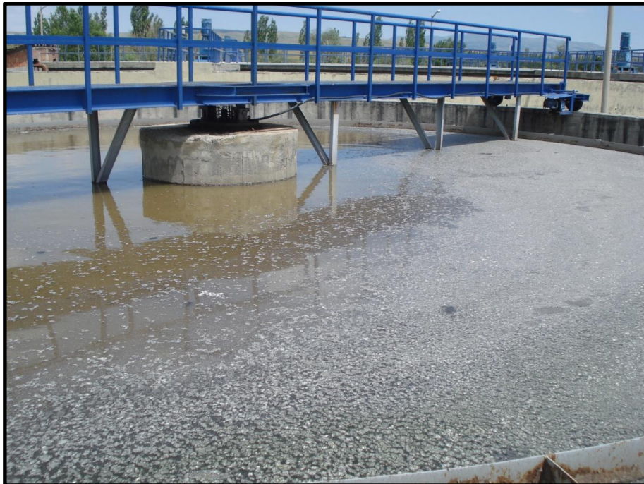
Şekil 3.59. Çorum Atıksu Arıtma Tesisi – Çamur Yoğunlaştırma Havuzu
