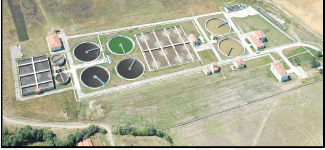
Şekil 3.47. Çorum Atıksu Arıtma Tesisi – Genel Görünüşü
