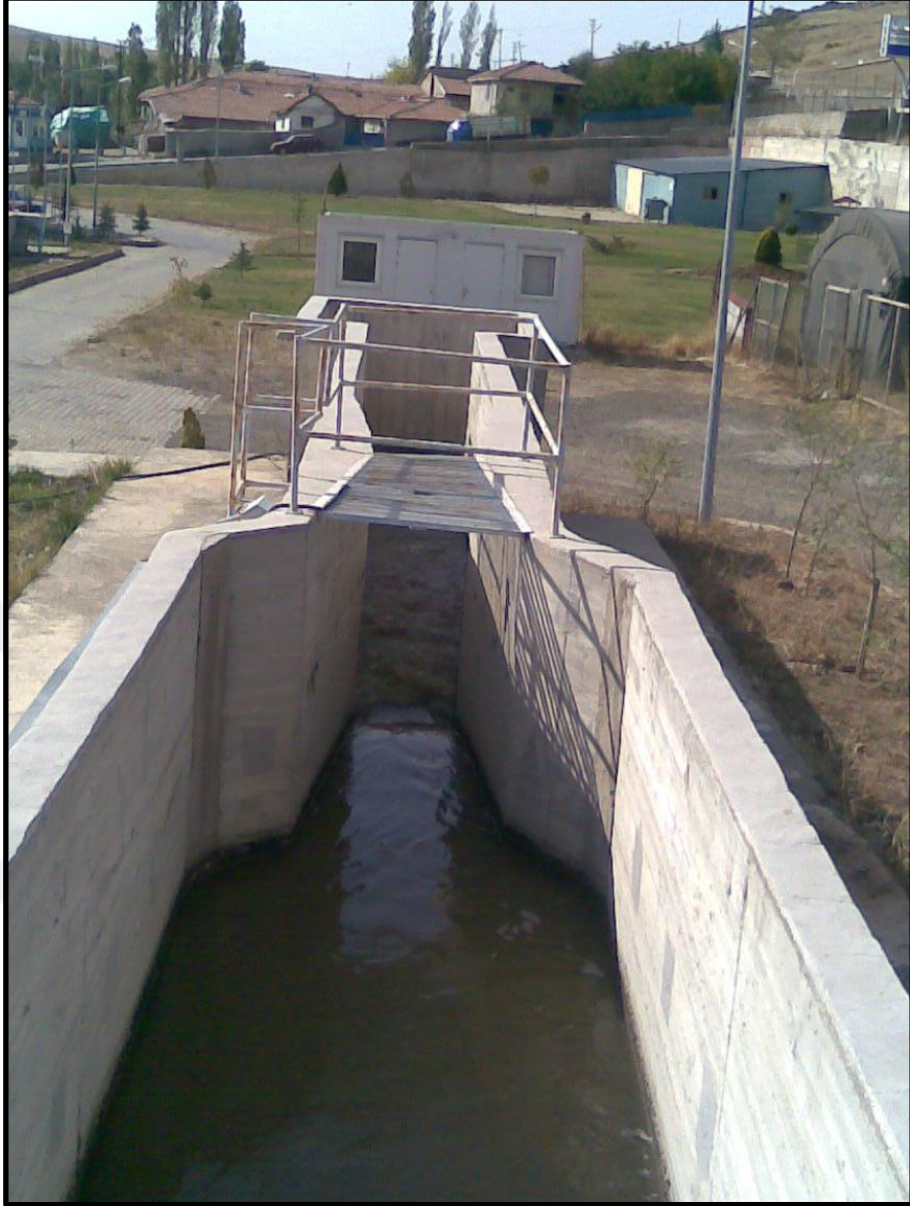
Şekil 3.9. Yozgat Atıksu Arıtma Tesisi – Kum Tutucu Havuzlar
