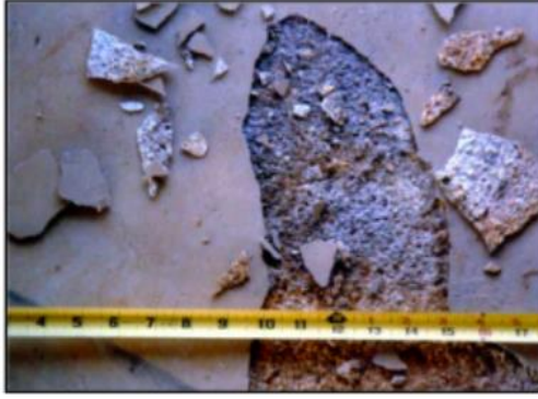
Şekil 2.27. Tabakalaşma [1]
