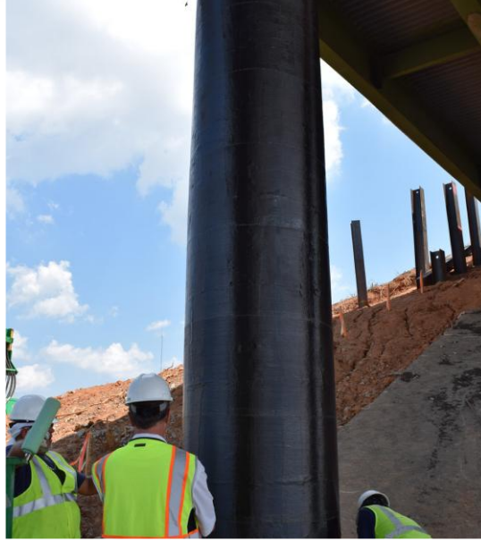
Şekil 2.11. Kolonda Bitmiş FRP Uygulaması [20]
