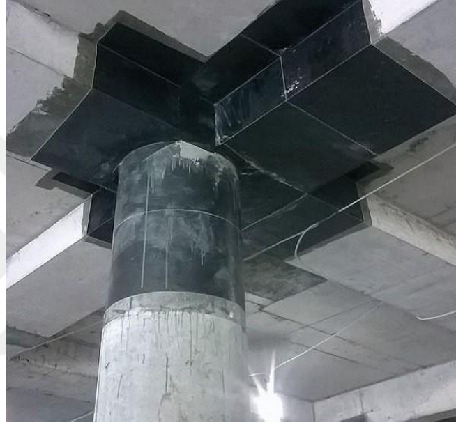
Şekil 2.12. Kolonda Bitmiş FRP Uygulaması [22]
