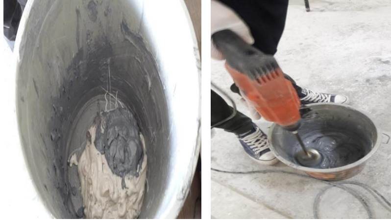
Şekil 4.14. Çift Bileşenli Epoksinin Hazırlanması
