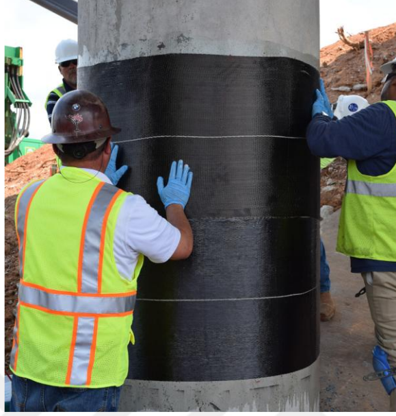
Şekil 2.10. FRP'nin Kolon Yüzeyine Uygulanması [20]
