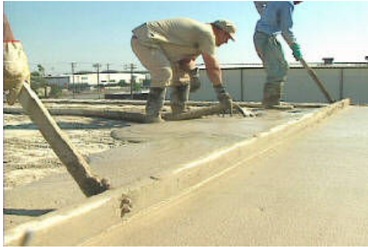
Şekil 2.17. Genleştirilmiş Vermikülit ile Yapılmış Hafif Betonun Teras Uygulaması [62].
