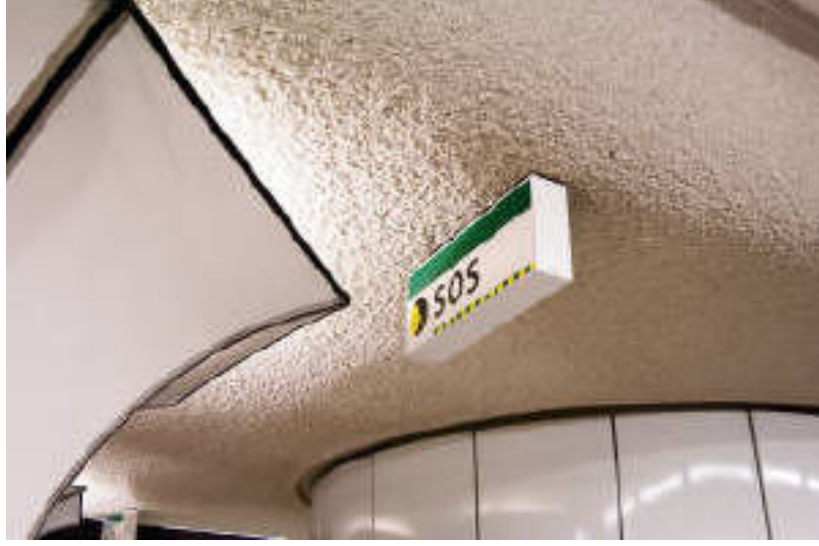
Şekil 2.18. Vermikülit Esaslı Tavan Sıvası Uygulaması [62].
