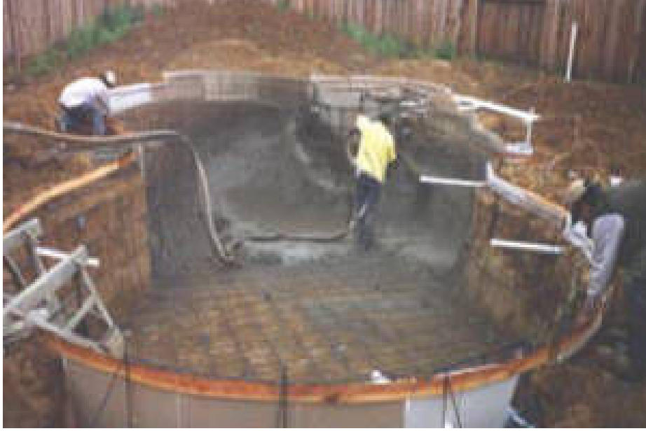
Şekil 2.21. Havuz Tabanında Püskürtme Genleştirilmiş Vermikülit Uygulaması [62].
