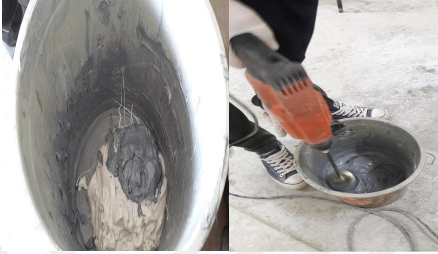
Şekil 5.15. Çift Bileşenli Epoksinin Hazırlanması
