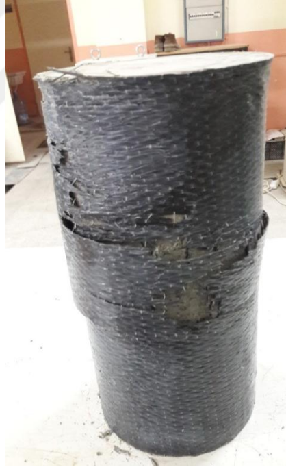
Şekil 5.34. CFRP-C75 Tek Sarım Beton Numunesi Deney Sonrası
