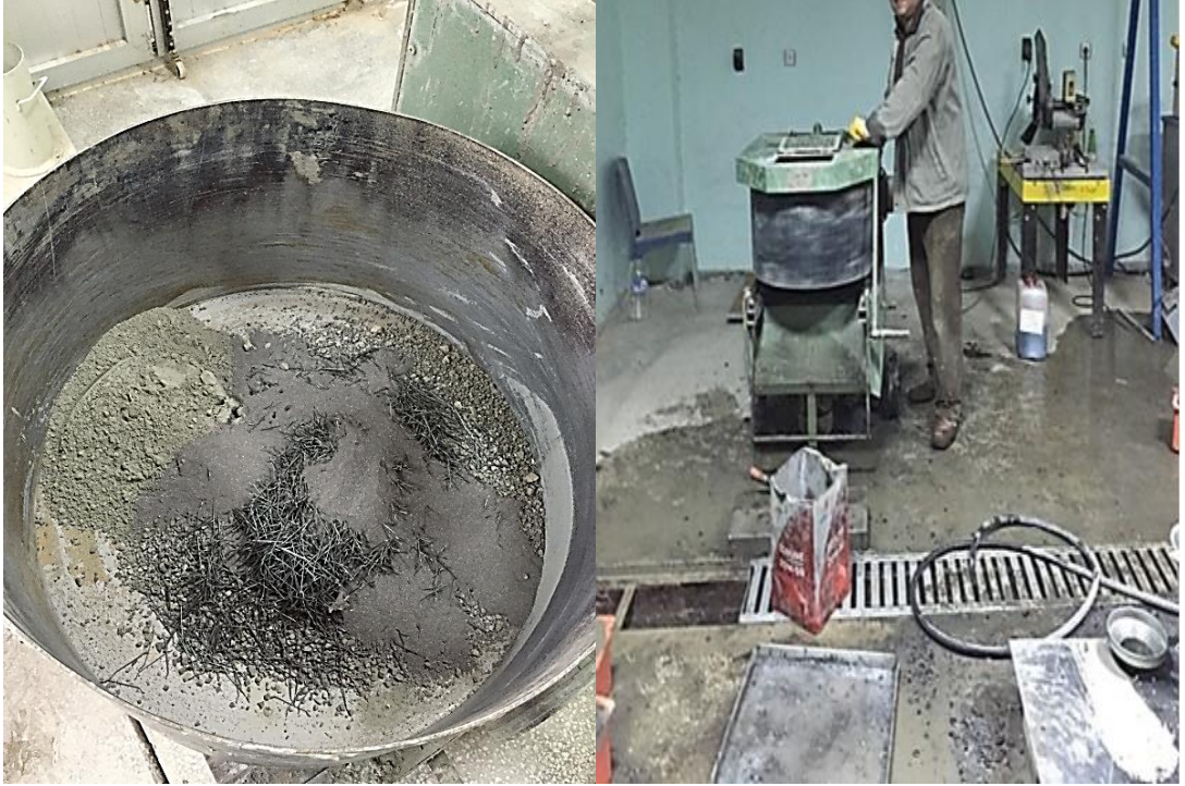
Şekil 3.9. Beton Karışımının Hazırlanması
