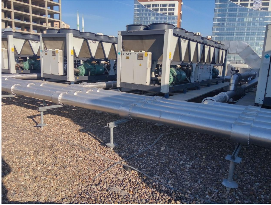
Őekil 3.11. Alıřveriř Merkezinde Bulunan Chiller Sisteminin Grnm
