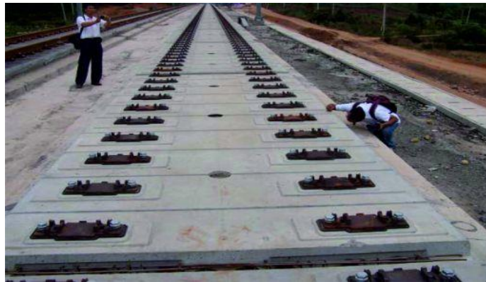
Şekil 2.4. Demiryolu döşemesinde bazalt lif kullanımı (Çin) [20]
