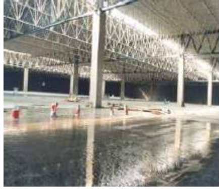
a) Zemin betonları
