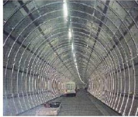
d) Tünel segmanları
