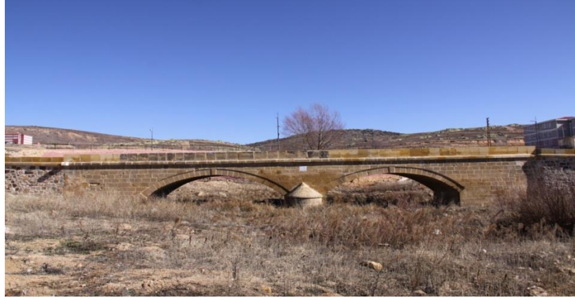
Şekil 5.2. Elekçi Köprüsü Kuzey Tarafı Görünüşü
