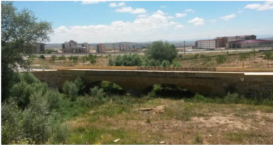
Şekil 5.1. Elekçi Köprüsü Güney Tarafı Görünüşü
