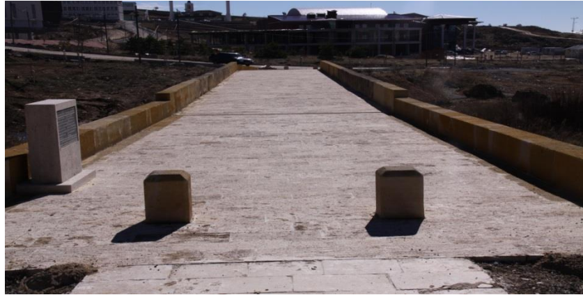
Şekil 5.4. Elekçi Köprüsü Doğu Tarafı Görünüşü
