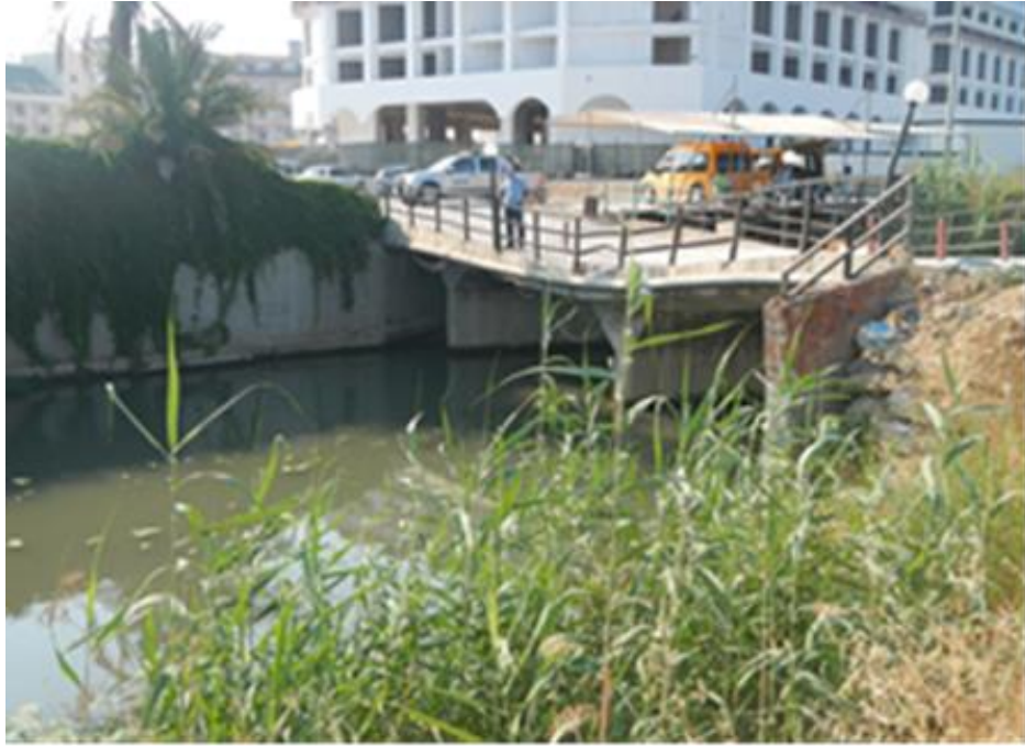
Şekil 5.18. Ilıca Deresi Km: 0+768.86'daki Sanat Yapısı
