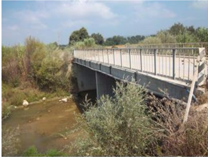
Şekil 5.14. Ilıca Deresi Km: 4+281.64'deki Sanat Yapısı
