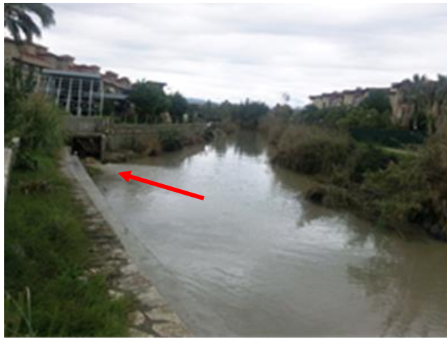
Şekil 5.13. Km: 0+250’deki Üzeri Kapatılan Derenin Ilıca Deresine Mansaplandığı Yer
