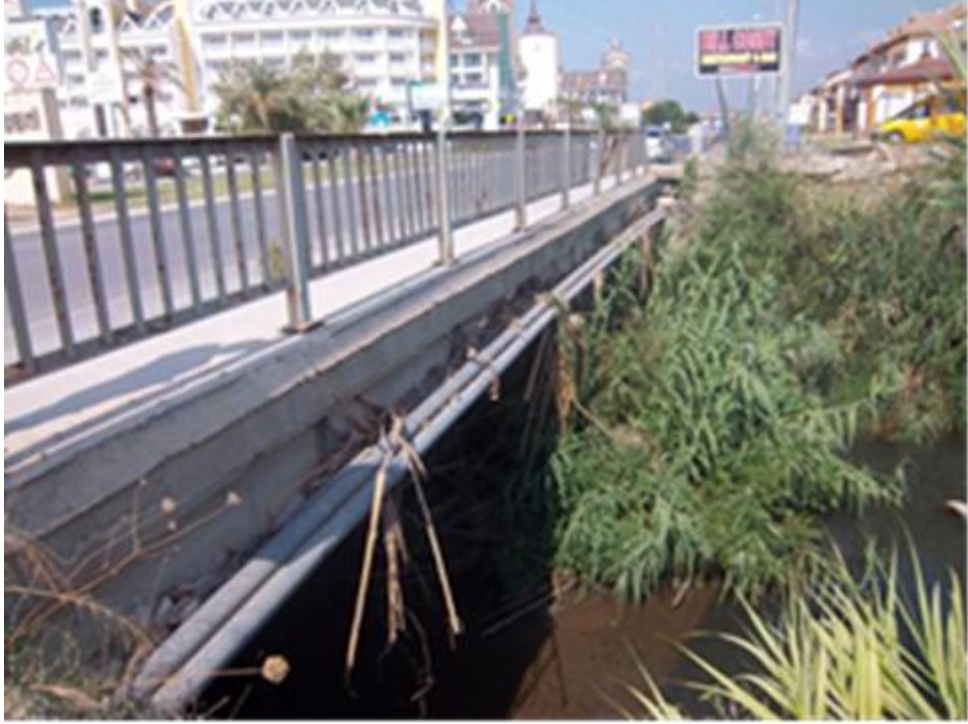
Şekil 5.17. Ilıca Deresi Km: 1+147.39'daki Sanat Yapısı
