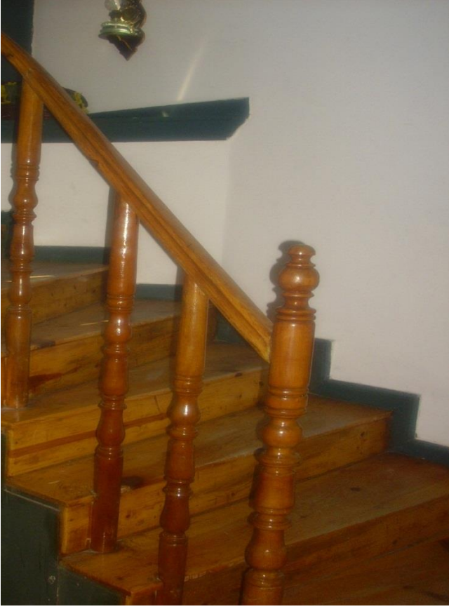
Fotoğraf 96: Ahşap Merdiven
