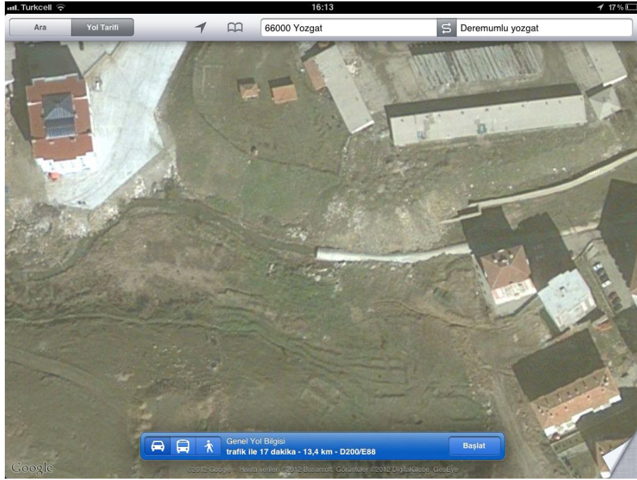
Şekil 6.13. Yozgat Atık Su Arıtma Bölgesi
