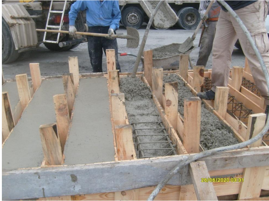
Şekil 3.3 Beton numuların üretimi-2
